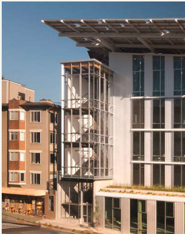
FIGURA 30: ESCADA IRRESISTÍVEL NA FACHADA. FONTE: BULLITT FOUNDATION, 2020
